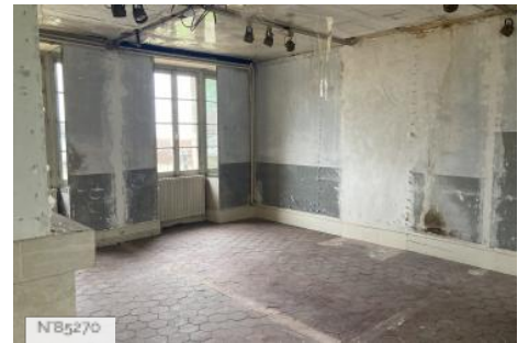
Chateau d'Hazeville - Appartement désaffecté
