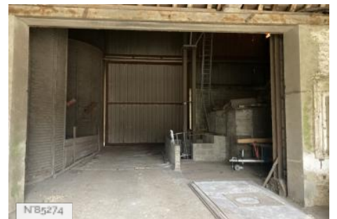
Chateau d'Hazeville - Silo
