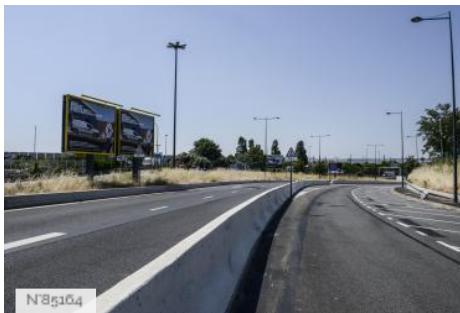
Marché International de Rungis - Route intérieure
