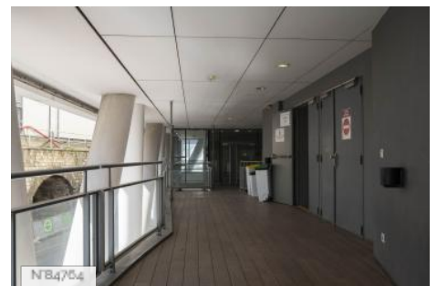
Ecole Nationale Supérieure d'Architecture (ENSA) Paris-Val de Seine - Passerelle extérieure
