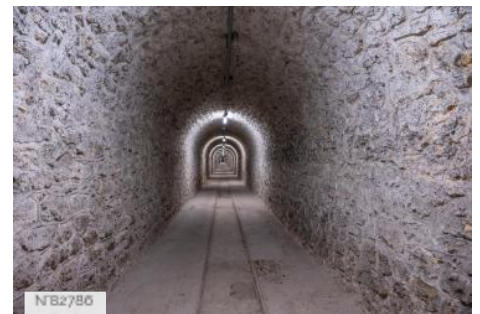
Fort de Saint-Cyr - Tunnel
