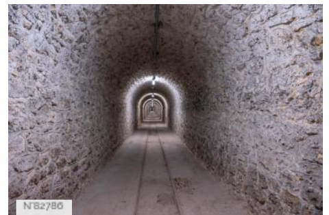
Fort de Saint-Cyr - Tunnel
