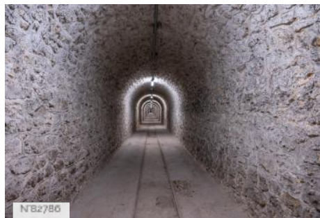
Fort de Saint-Cyr - Tunnel
