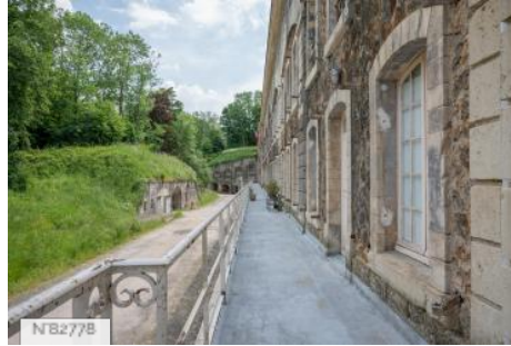
Fort de Saint-Cyr - Balcony
