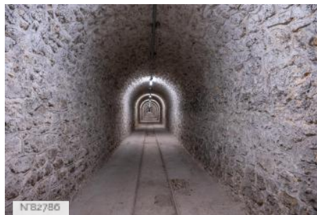
Fort de Saint-Cyr - Tunnel
