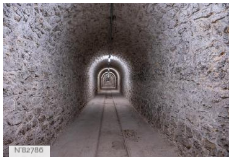
Fort de Saint-Cyr - Tunnel
