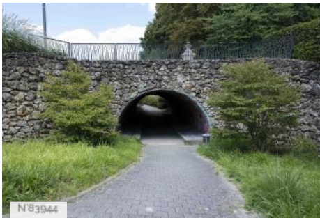
Parc de Noisiel - Tunnel
