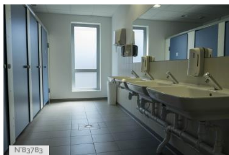
N83783 Aéroport de Paris - Le Bourget - Bâtiment AFMAE - Toilettes
