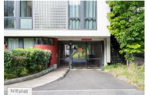
Cité de Refuge - Quai de déchargement
