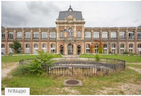
Hôpitaux de Saint-Maurice - Cour d'Honneur of the national site
