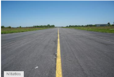
Aérodrome de Melun-Villaroche - Taxiway
