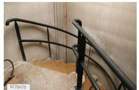
MC93 - Maison de la Culture de Seine-Saint-Denis- Access staircase to the grill, fire tower
