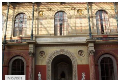
N°07081 Ecole nationale supérieure des Beaux-arts - Glass courtyard
