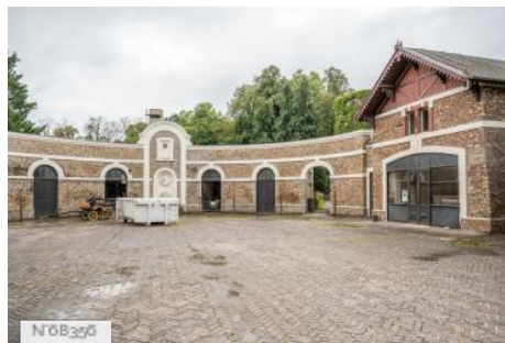
Domaine de la Grange-La Prévôté - Stables
