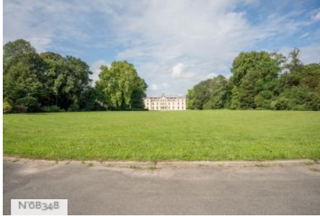
Domaine de la Grange-La Prévôté - Exteriors
