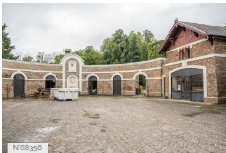
Domaine de la Grange-La Prévôté - Stables
