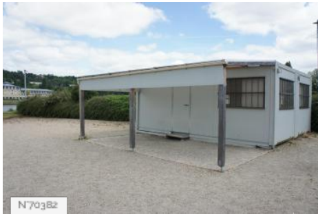
Ville des Mureaux - Boulodrome
