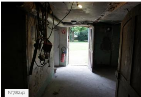
N78241 City of Les Mureaux - House of Oseraie - Basement
