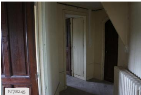
City of Les Mureaux - House of Oseraie - Attics
