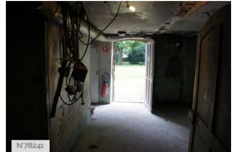
City of Les Mureaux - House of Oseraie - Basement
