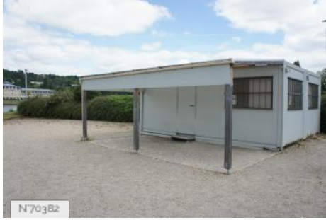
Ville des Mureaux - Boulodrome
