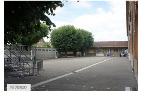
Ville des Mureaux - School Roux Calette - Schoolyard
