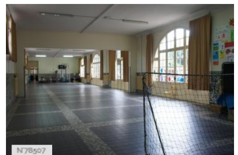
N78507 Ville des Mureaux - School Roux Calemente - Multipurpose hall
