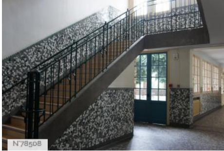
Ville des Mureaux - School Roux Calemente - Staircase
