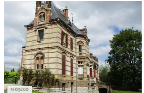
Ville des Mureaux - House of Oseraie - Outside
