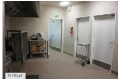
City of Les Mureaux - The Pôle Molière - Self service / Canteen
