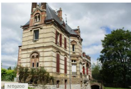
Ville des Mureaux - House of Oseraie - Outside
