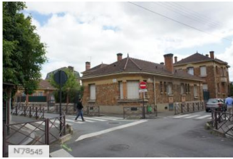
Ville des Mureaux - School Roux Calette - Outside
