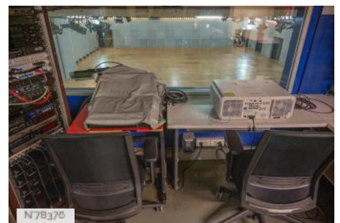
N78375 Cité des Sciences et de l'Industrie - Congress centre/Louis Armand control room
