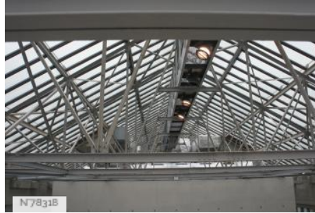
Musée de l'Orangerie - attic / machine room
