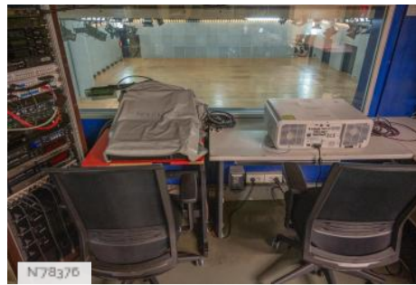
Cité des Sciences et de l'Industrie - Congress centre/Louis Armand control room
