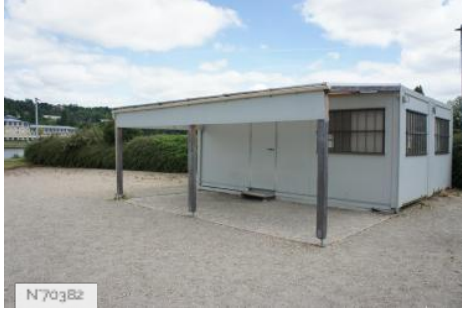
Ville des Mureaux - Boulodrome
