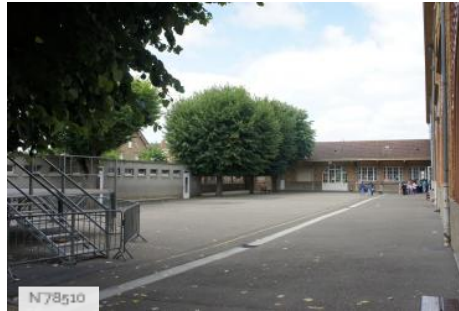
Ville des Mureaux - School Roux Calemente - Schoolyard
