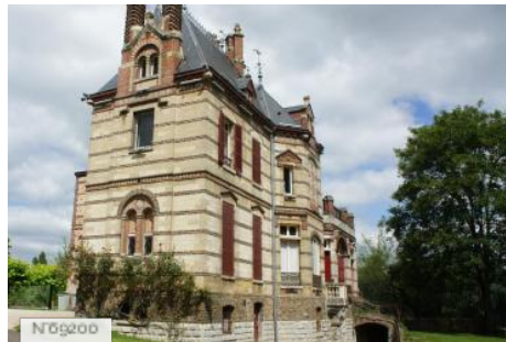
Ville des Mureaux - House of Oseraie - Outside
