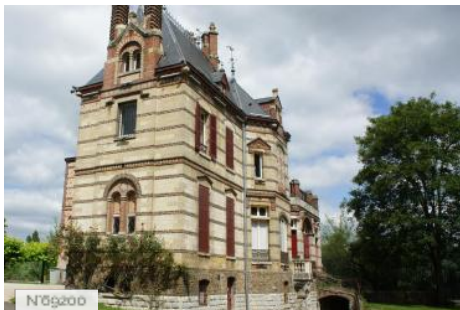
Ville des Mureaux - House of Oseraie - Outside
