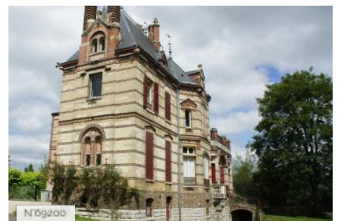
Ville des Mureaux - House of Oseraie - Outside
