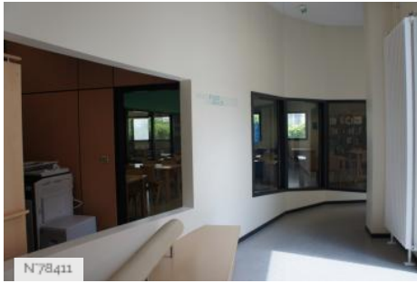
Ville des Mureaux - Media library - Glazed corridor
