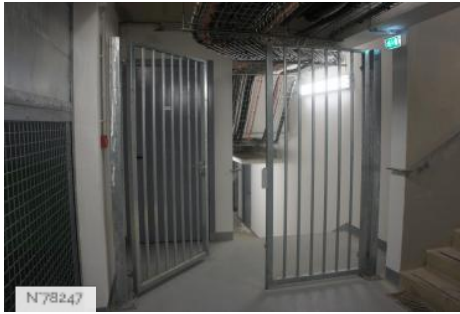
City of Les Mureaux - The Pôle Molière - Parking
