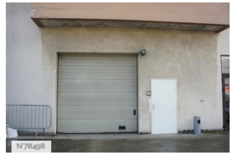
N78498 City of Nogent-sur-Marne - La Scène Watteau - Outside
