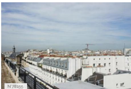
N78155 École Duperré - Terrace
