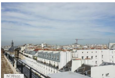
N78155 École Duperré - Terrace
