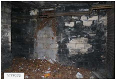
La maison d'Education des Loges - Basement
