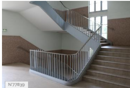
La maison d'Education des Loges - Staircase n°2
