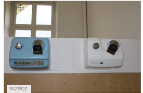
La maison d'Education des Loges - Alley dormitory sanitories
