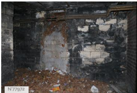
La maison d'Education des Loges - Basement
