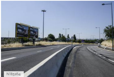
Marché International de Rungis - Route intérieure
