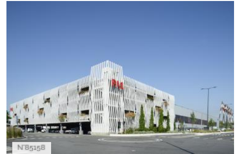
Marché International de Rungis - Parking silo
