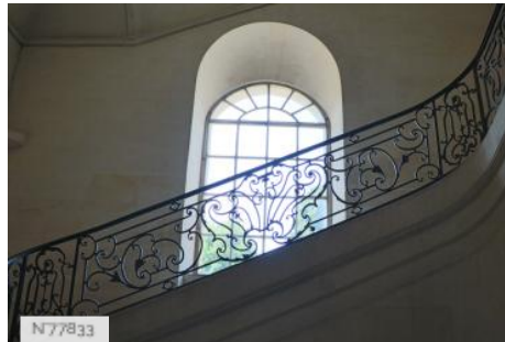
N77833 Maison d'Education de la Légion d'Honneur - Older staircases
