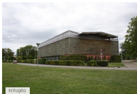
Jouy-en-Josas city - Domaine de la Cour Roland/Covered tennis courts
