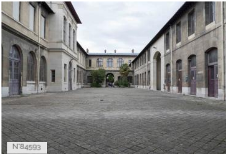
Ecole Nationale Vétérinaire d'Alfort - Paved courtyard
