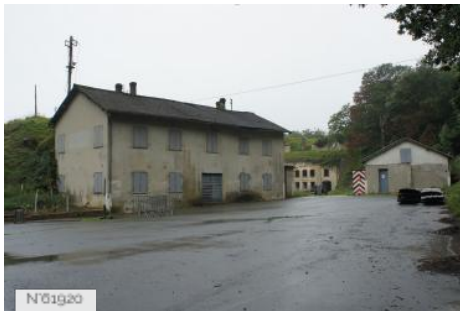
N 01920 Cormeilles Fort - Exteriors
