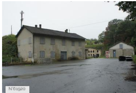
N 01920 Cormeilles Fort - Exteriors
