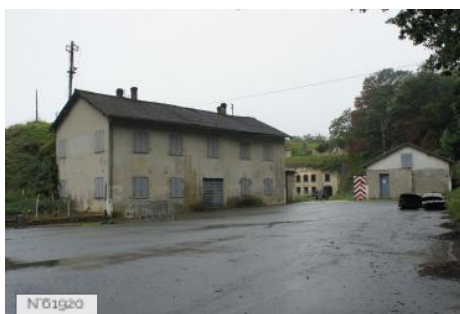
N 01920 Cormeilles Fort - Exteriors
