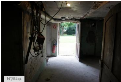
City of Les Mureaux - House of Oseraie - Basement
