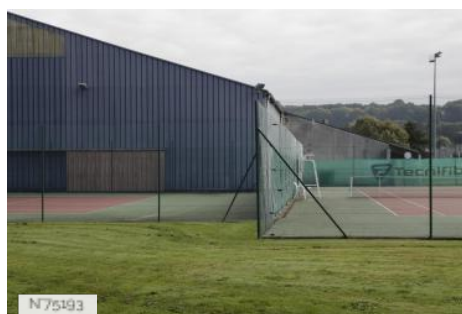
Stade Louis Biemann - Courts de tennis intérieurs et extérieurs
