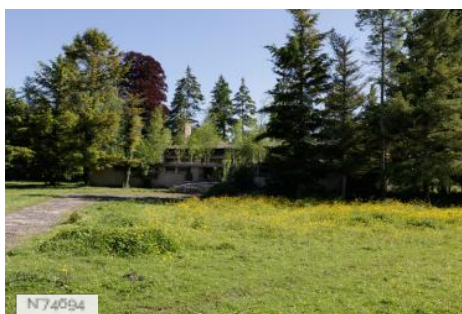
Bâtiments en rénovation
